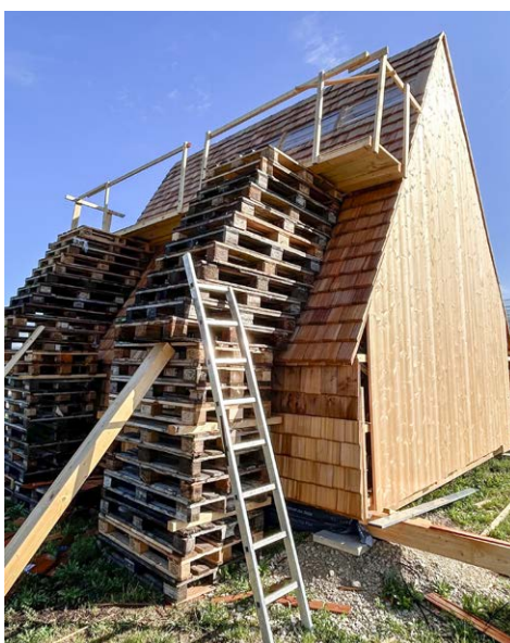
Ein improvisiertes Baugerüst für die Dacharbeiten
